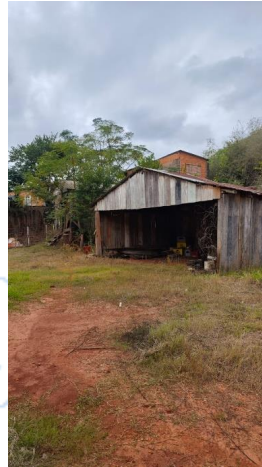
Imagem 2 – Construções no local de execução da obra
