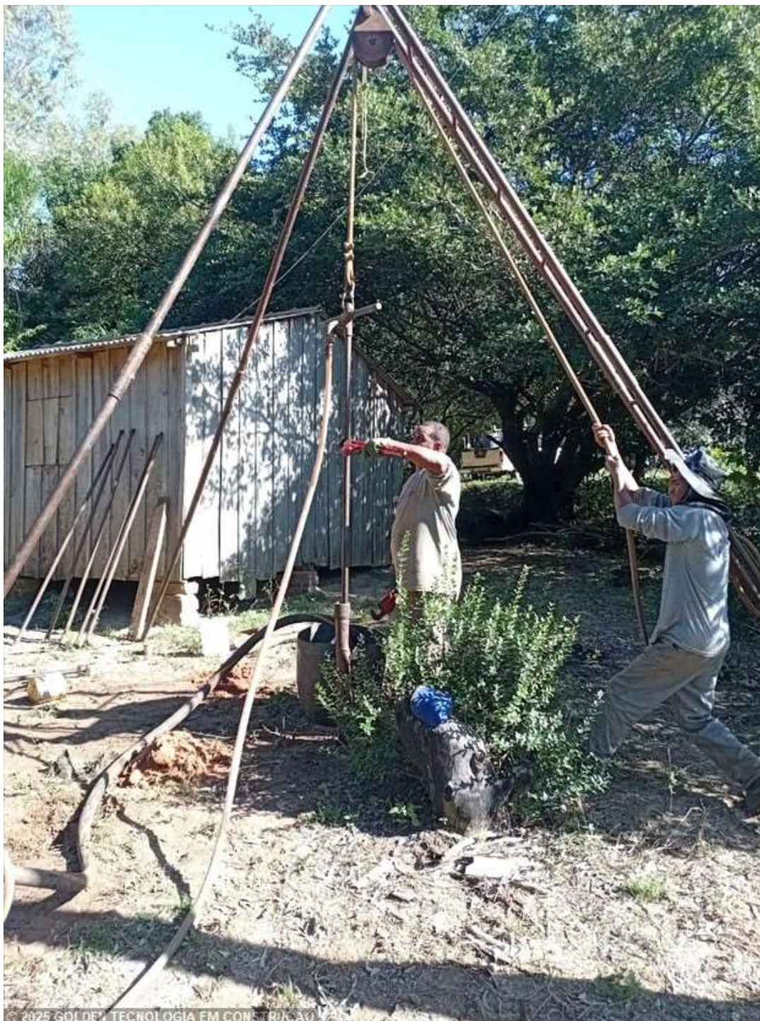
Foto 1 – FOTO SP 8.B - SEC. OBRAS DO RIO GRANDE DO SUL - EST. ITAPUA COLONIA, 525, ITAPUA - VIAMÃO - RIO GRANDE DO SUL - 29.05.25
