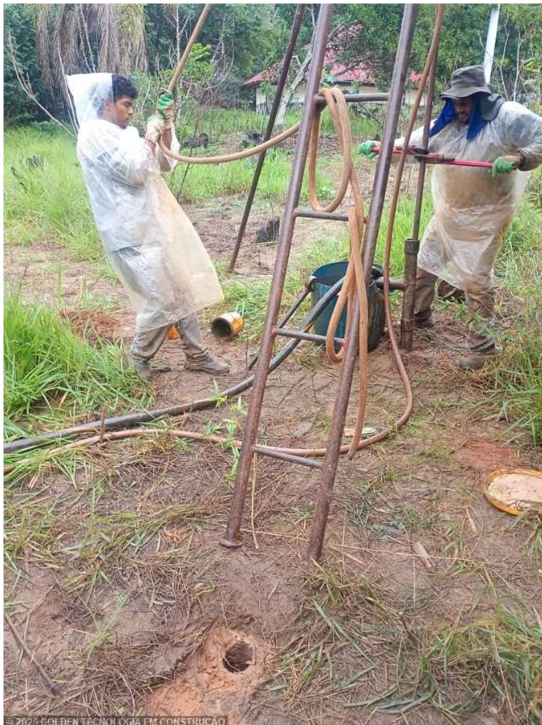
Foto 1 – FOTO SP 9.B - SEC. OBRAS DO RIO GRANDE DO SUL - EST. ITAPUA COLONIA, 525, ITAPUA - VIAMÃO - RIO GRANDE DO SUL - 29.05.25
