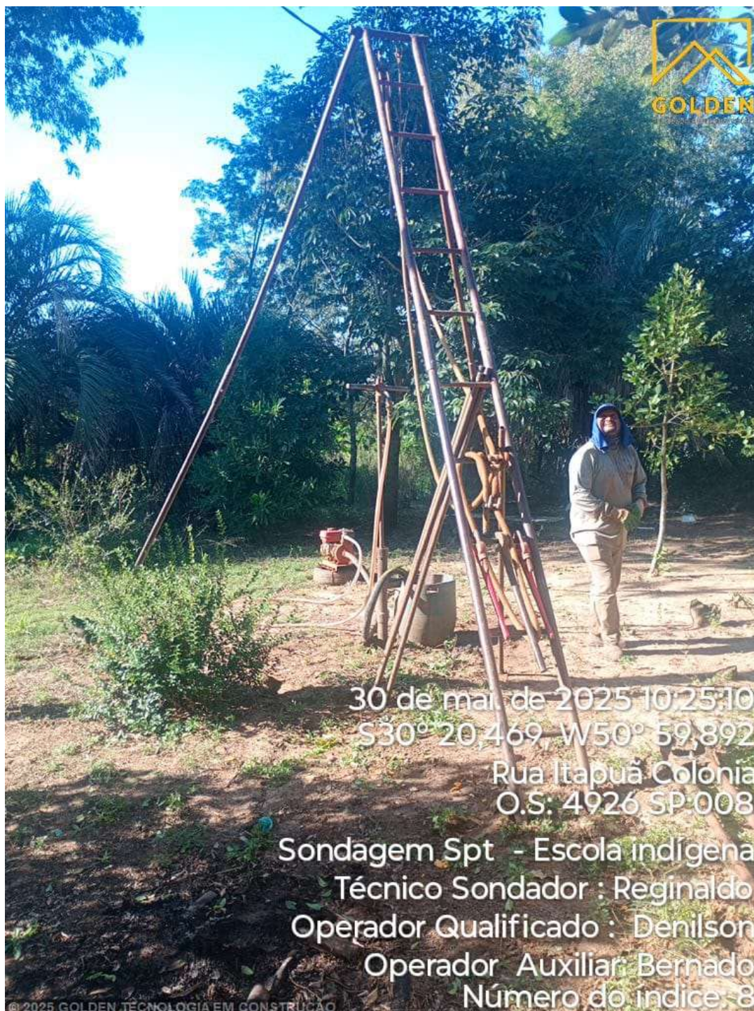
Foto 1 – FOTO SP 8.C - SEC. OBRAS DO RIO GRANDE DO SUL - EST. ITAPUA COLONIA, 525, ITAPUA - VIAMÃO - RIO GRANDE DO SUL - 29.05.25
