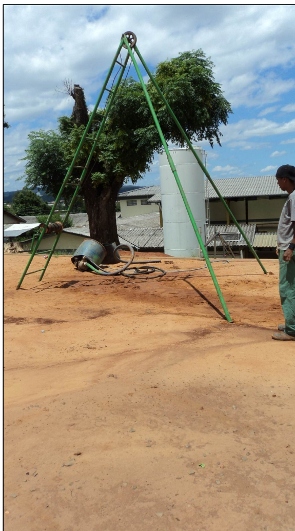
Foto 1 – Local de execução das sondagens
