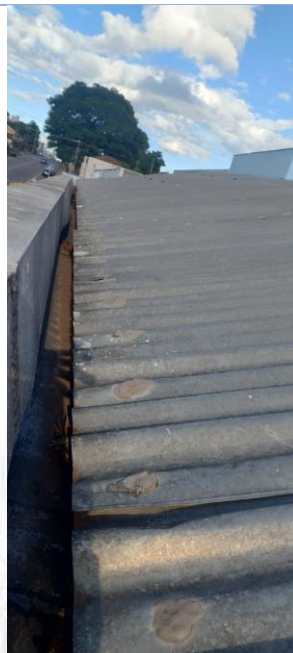
Manutenção de calhas e limpeza calha de platibanda da frente do prédio e instalação de tela - 3
