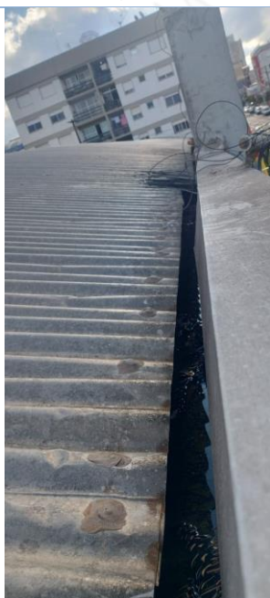
Manutenção de calhas e limpeza calha de platibanda da frente do prédio e instalação de tela - 3
