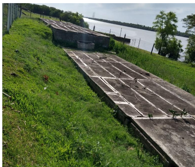
Sistema de fossa-filtro da PEJ – ambos sistemas estão inoperantes, com a estrutura danificada e extravasando esgoto sanitário bruto diretamente no Rio Jacuí
