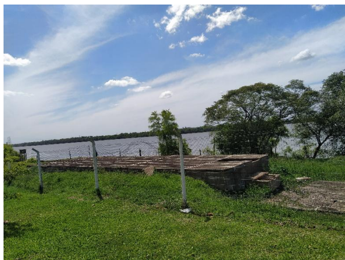
Sistema de fossa-filtro da PEJ – ambos sistemas estão inoperantes, com a estrutura danificada e extravasando esgoto sanitário bruto diretamente no Rio Jacuí
