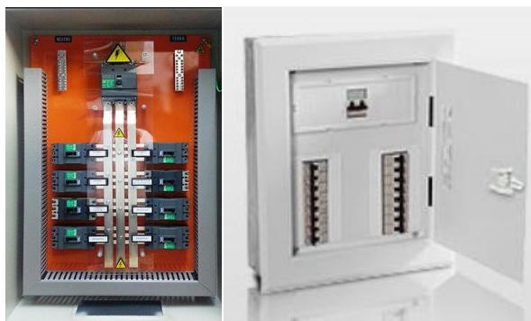
Figura 8 – Características construtivas do QGGT a ser instalado no ginásio.
