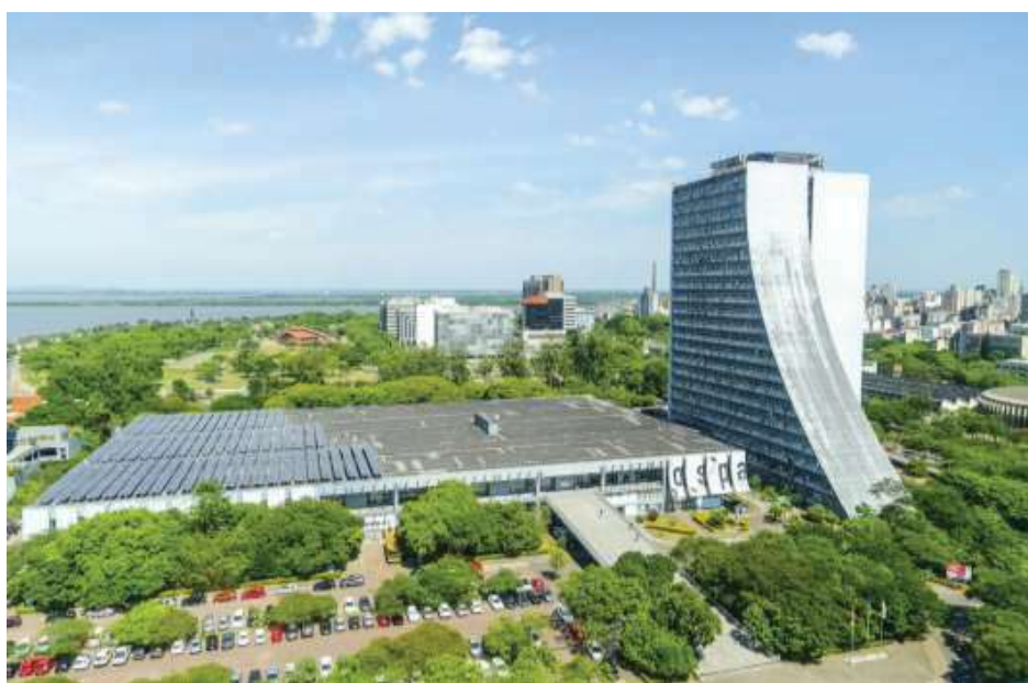
Prédio SEDUC RS à esquerda.
