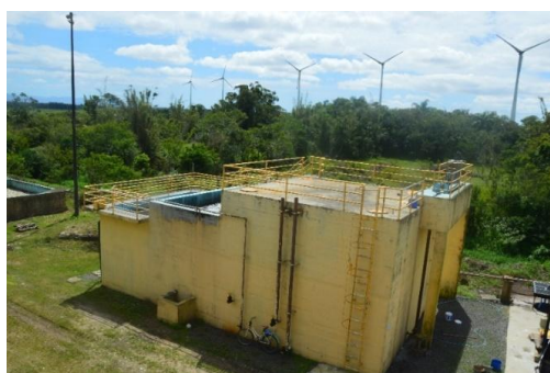
Figura 2. Estação de Tratamento de Esgoto da PMEO
