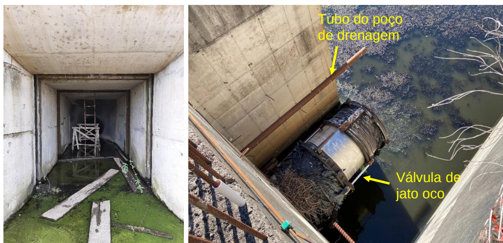
Figura 48 – Tomada d'água lado montante e lado jusante (válvula de jato oco).
