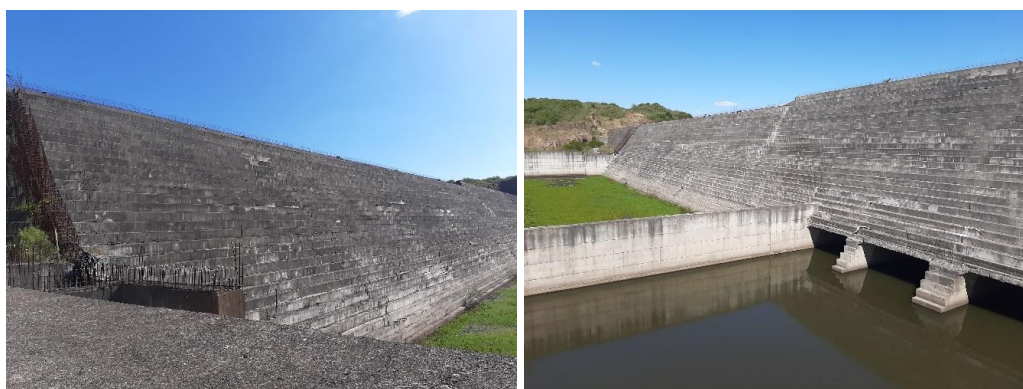
Figura 41 – vista geral da face de jusante a partir da ombreira direita e da esquerda, respectivamente.
