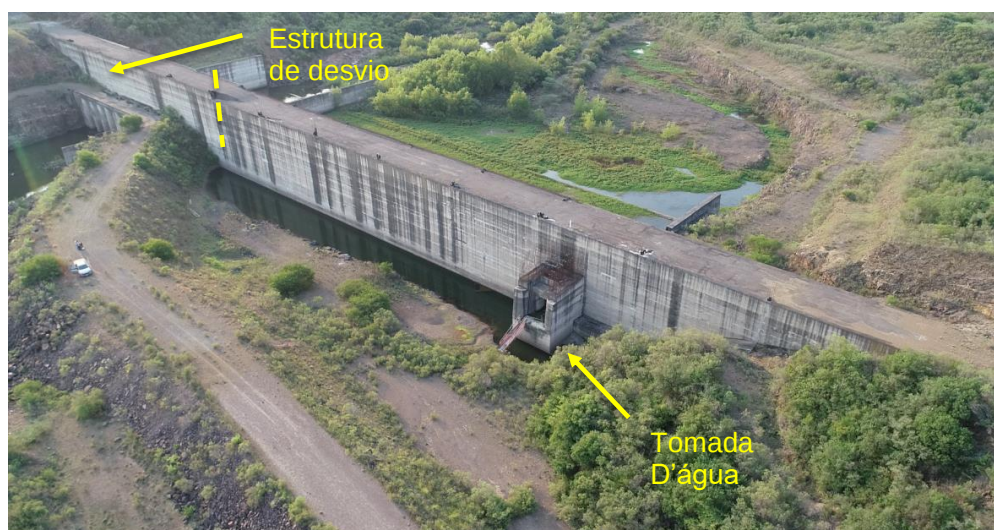
Figura 29 – Vista panorâmica da face de montante pelo lado direito.
