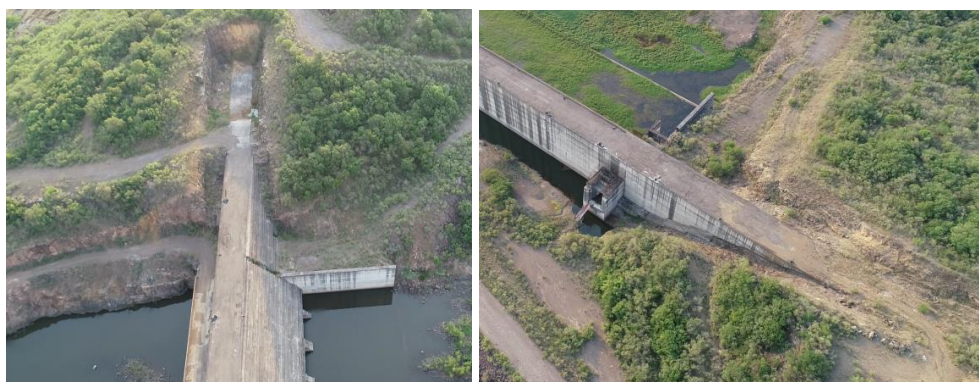
Figura 10 – foto panorâmica, da ombreira esquerda e direita, respectivamente.
