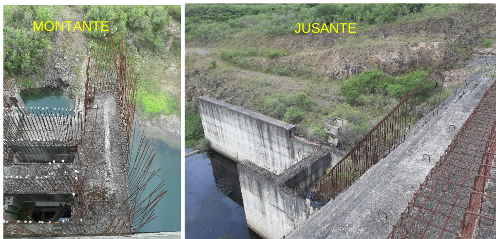
Figura 50 – Estrutura inacabada da tomada d'água. Montante e jusante, respectivamente.
