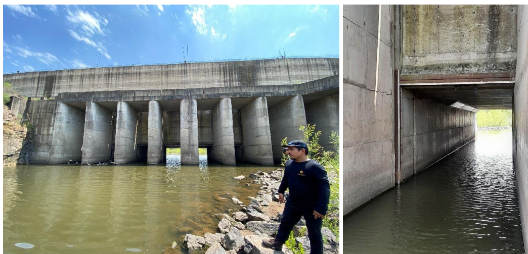
Figura 33 – Adufa (estrutura de desvio do arroio) vista de baixo e detalhe dos nichos das comportas.
