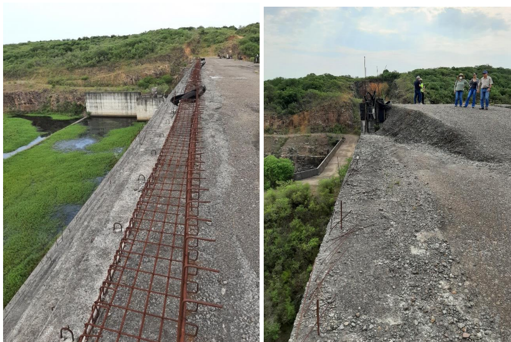
Figura 45 – Vista do topo para o lado de jusante (detalhe da armadura na Figura 40 aparente) e vista do topo para o lado de montante com destaque para a rampa em CCR ao fundo.
