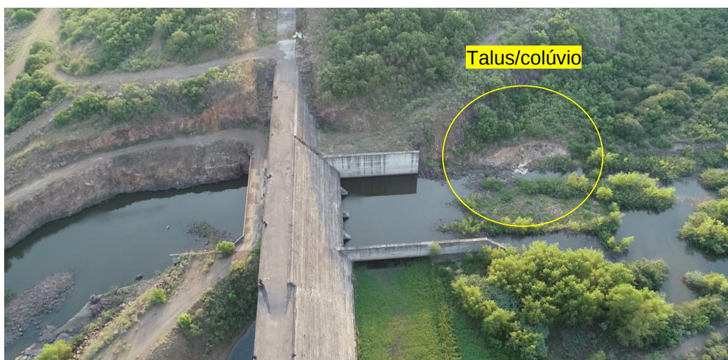
Figura 12 – vista dos taludes da margem esquerda.
