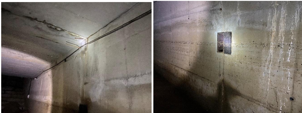
Figura 25 – Aspectos das juntas entre blocos.
