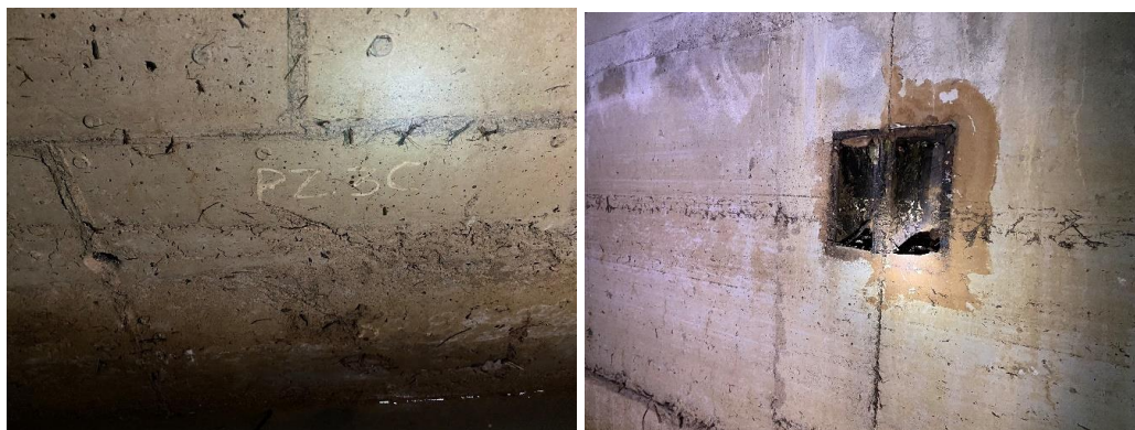
Figura 26 – Marcação de posição da instrumentação (PZs) e nicho para receber medidores triortogonais.
