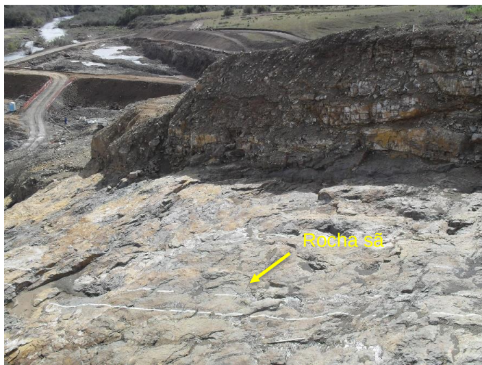
Figura 8 – foto da escavação próximo a ombreira.
