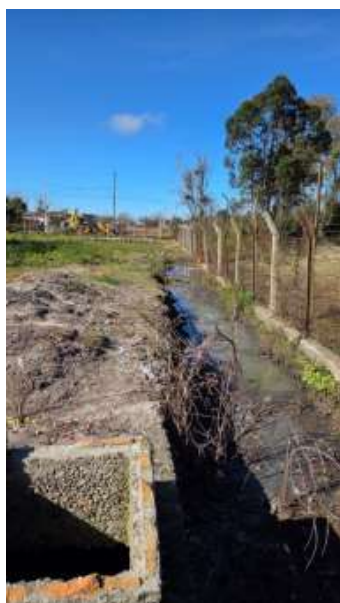
Figura 1 – Esgoto bruto a céu aberto
