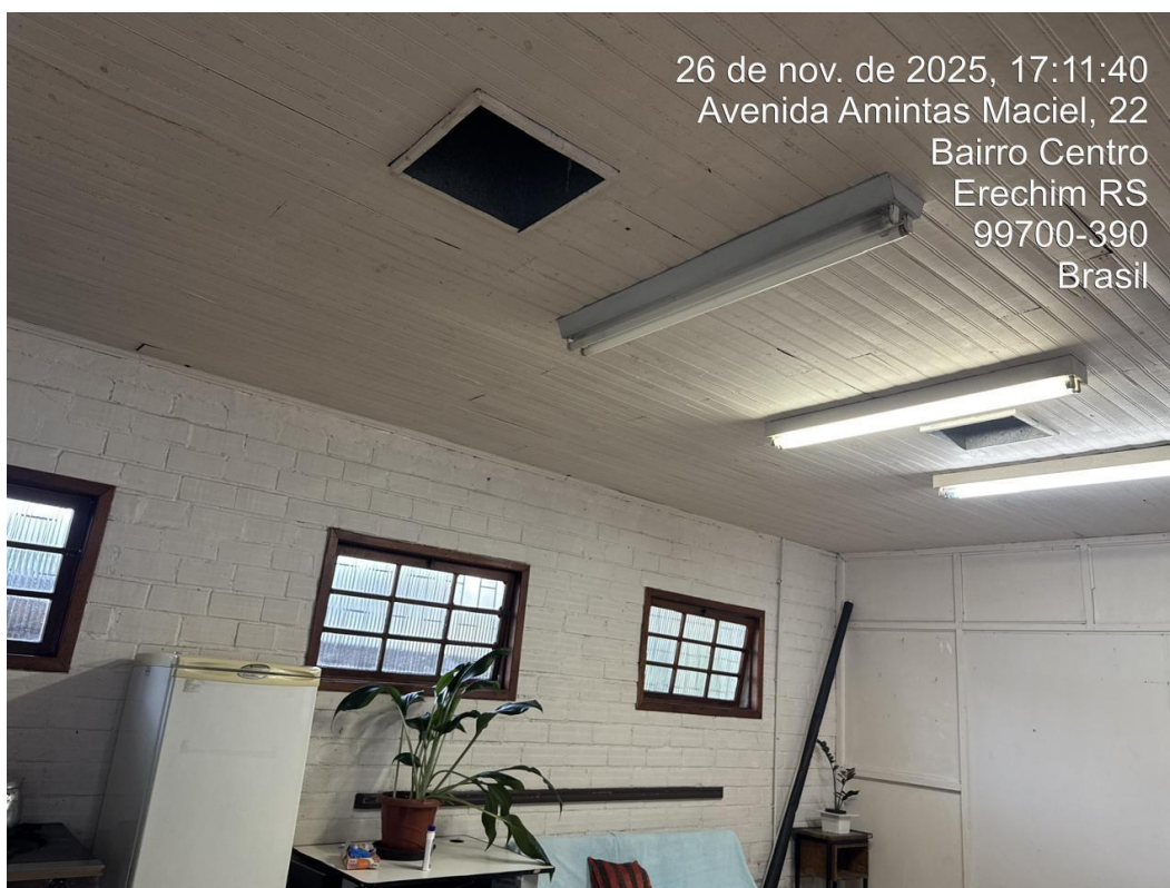
3- Forro da edificação.
