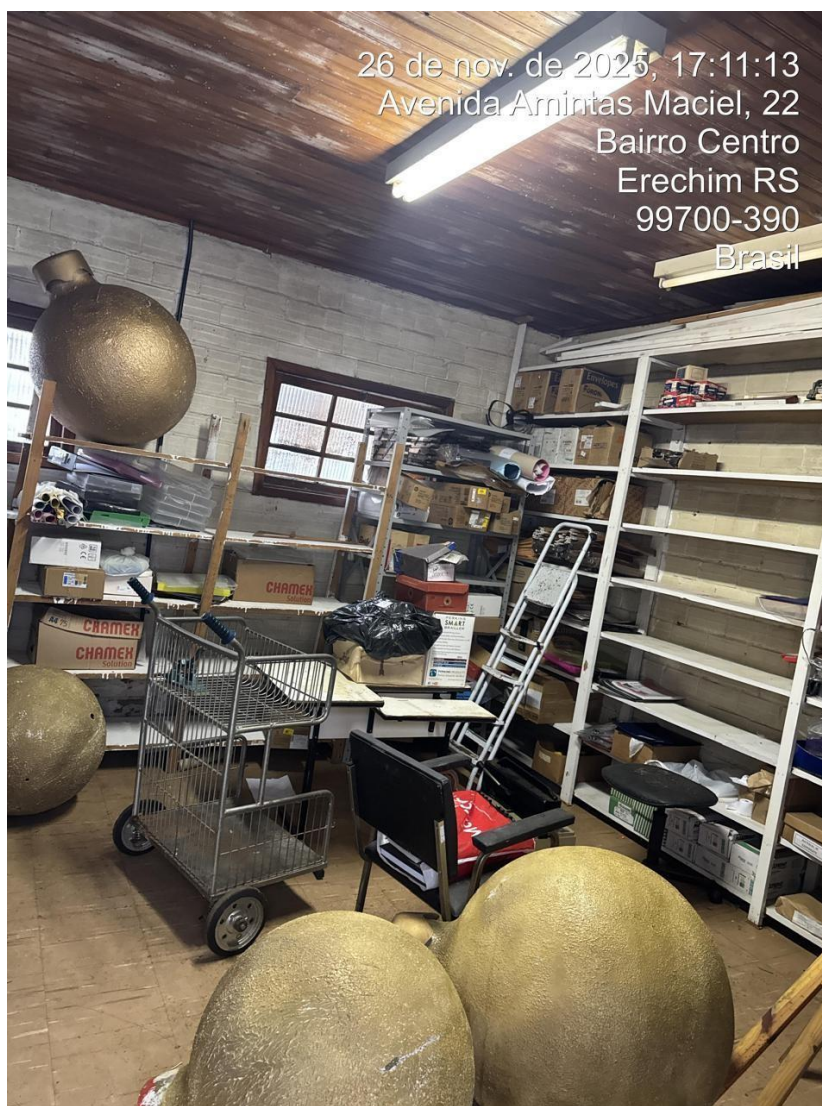
6- Forro do depósito.
