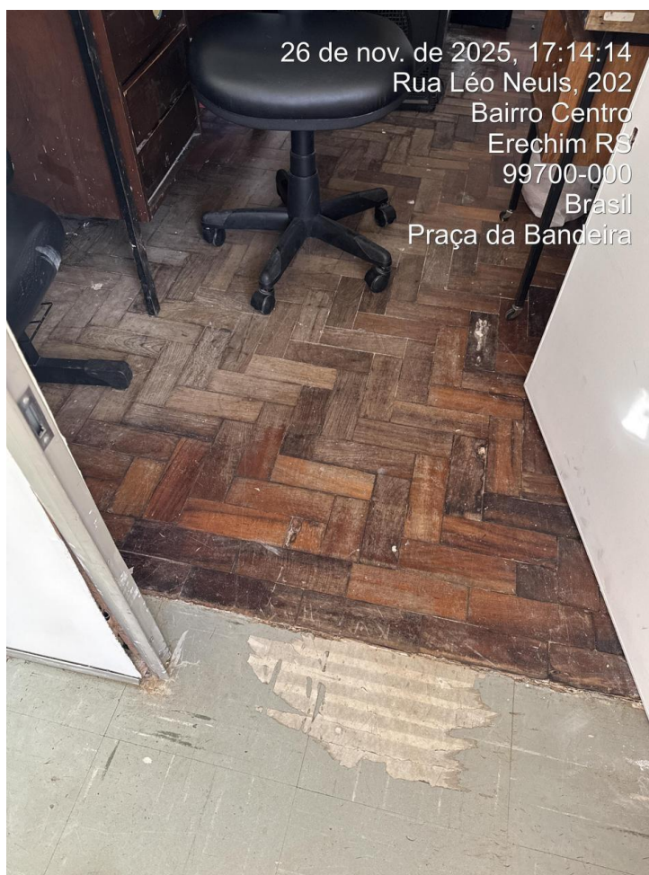
5- Piso da edificação.
