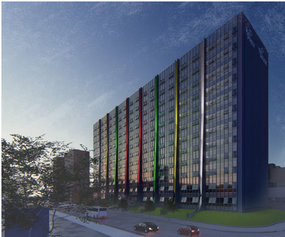
Figura 8: Ilustração do aspecto geral projetado para a iluminação do conjunto, neste caso ilustrado com o exemplo do uso das cores verde, vermelho e amarelo para a Semana Farroupilha, efeito que será possibilitado pelo Sistema de Controle e Automação que será instalado.
