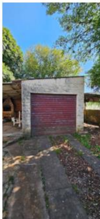
Figura 10 - Pintura e manutenção
