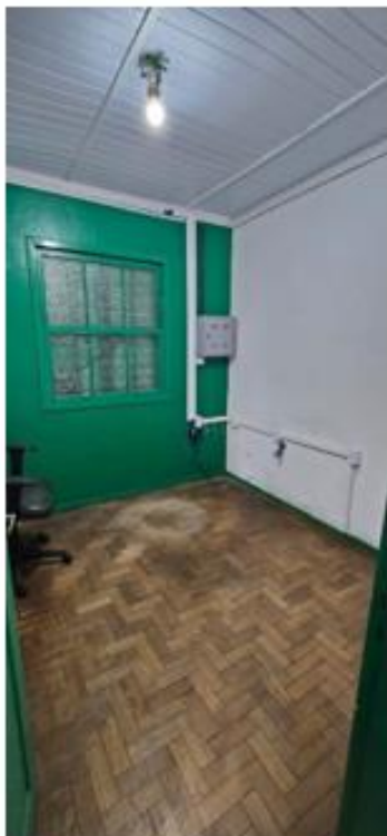
Figura 5 - Pintura de parede e limpeza piso
