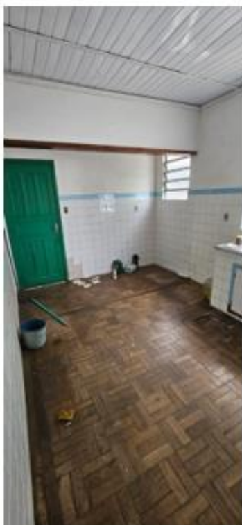
Figura 9 - Pintura e limpeza
