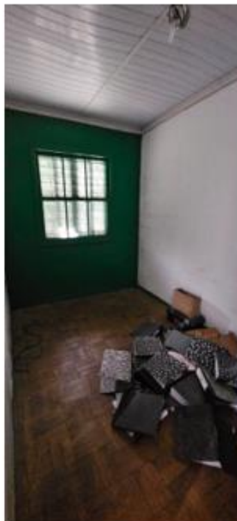
Figura 6 - Pintura de parede e limpeza piso
