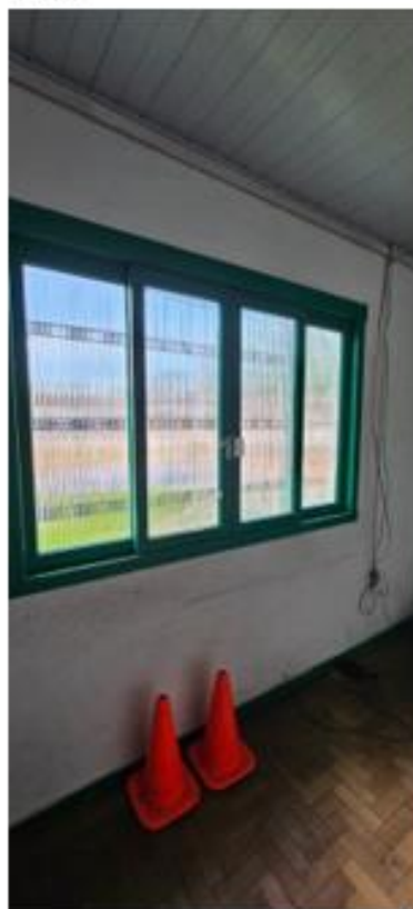
Figura 4 - Pintura esquadria e troca de vidro quebrado
