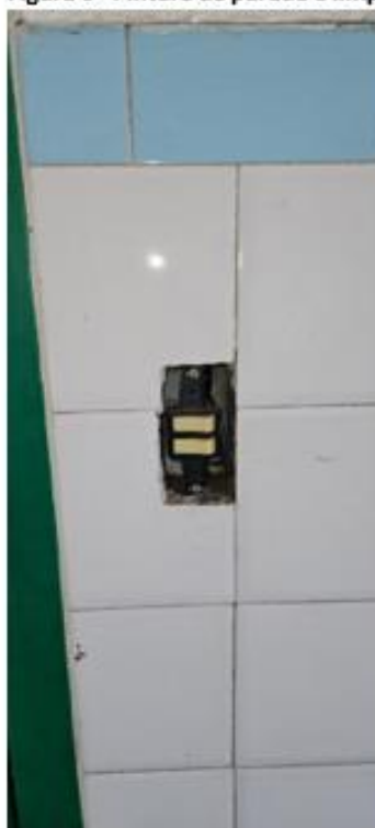
Figura 8 - Recolocação de espelho
