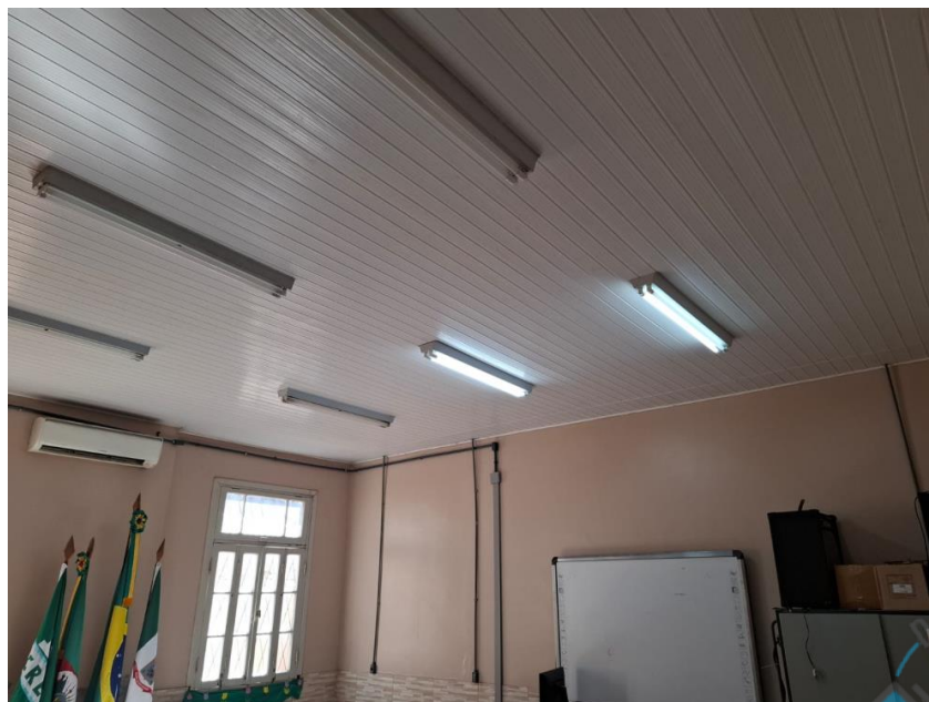
Foto 5: Vista interna de uma das dependências interditadas da edificação
