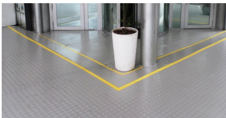
Fig. 07 – Revestimento piso tipo bus
