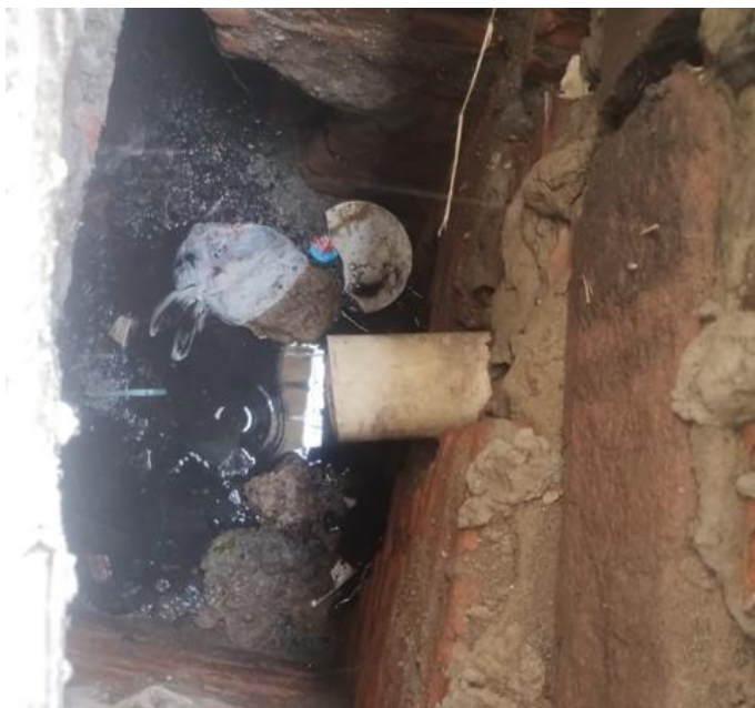
Figura 10 - Evidencia de entulho e lixo na rede (registro 22/03/2025) Fonte – Bourscheid (2025)
