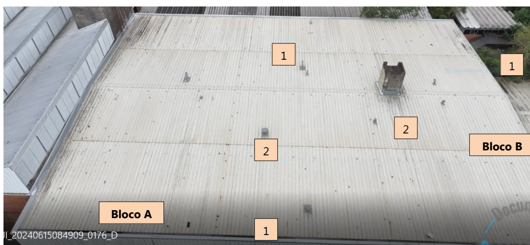
Figura 03: Blocos A e B | 1: Troca das calhas, 2: Troca do capeamento dos dutos.
