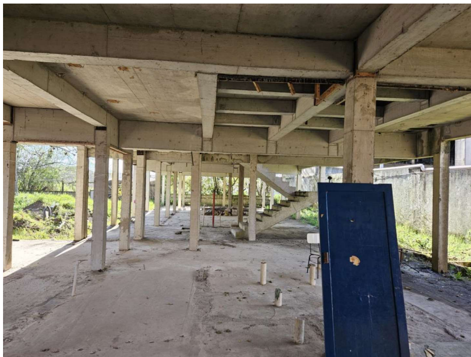
Foto 01 – Pavimento Térreo – Edificação Estrutural Existente
