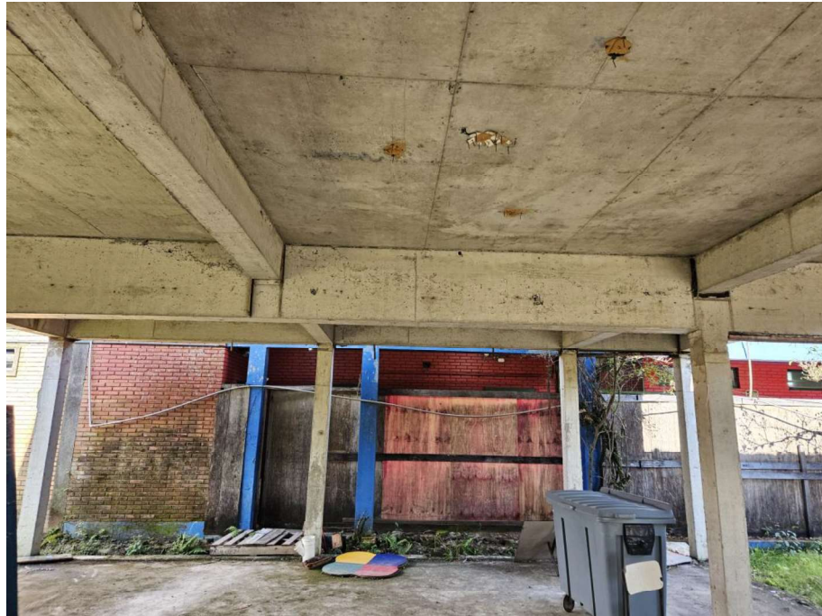
Foto 03– Pavimento Térreo – Edificação Estrutural Existente
