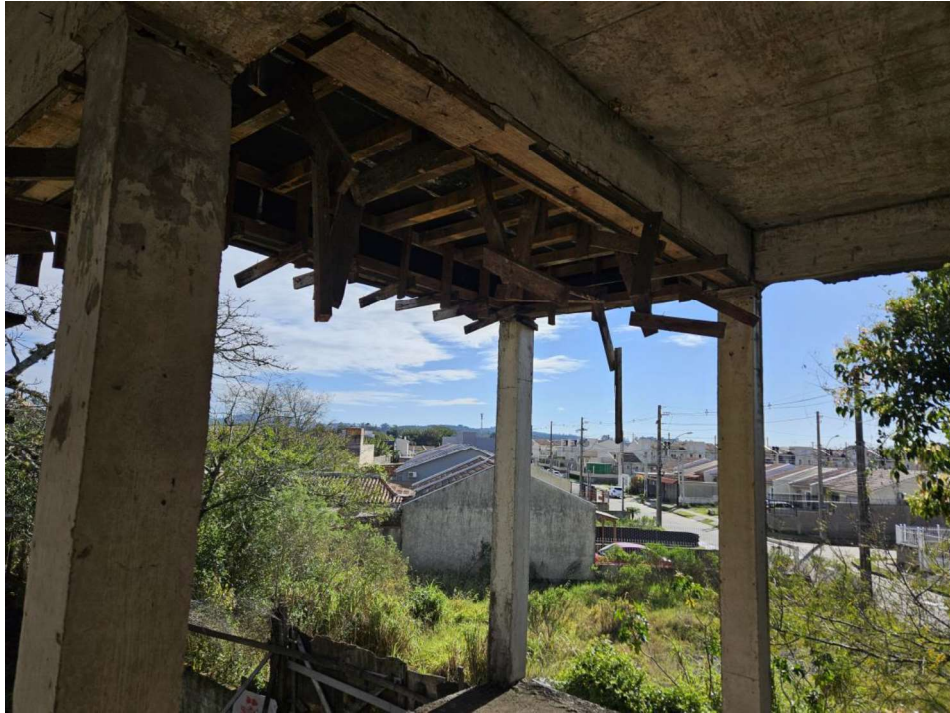
Foto 13 – 2º Pavimento – Edificação Estrutural Existente
