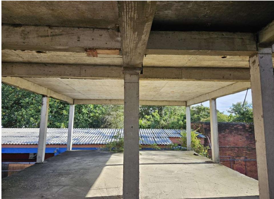
Foto 09 – 2º Pavimento – Edificação Estrutural Existente
