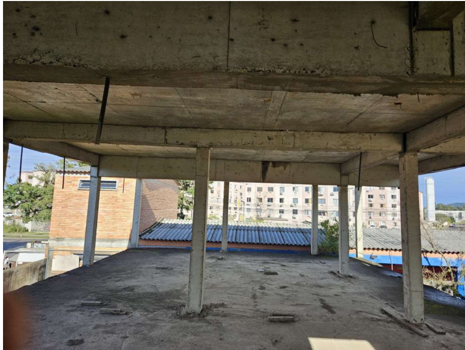
Foto 07– 2º Pavimento – Edificação Estrutural Existente
