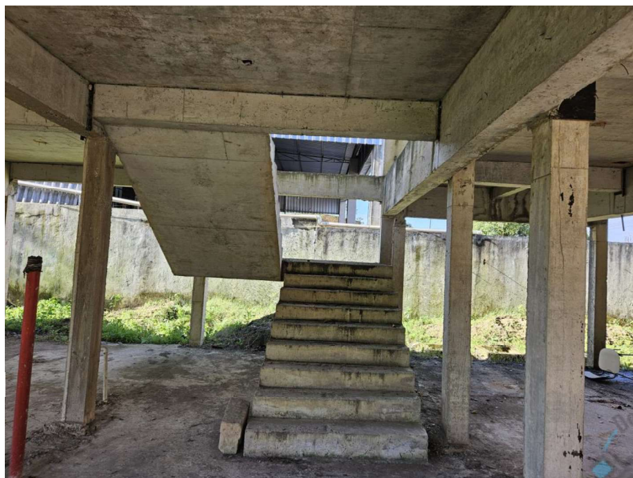
Foto 04 – Pavimento Térreo – Edificação Estrutural Existente - Escada
