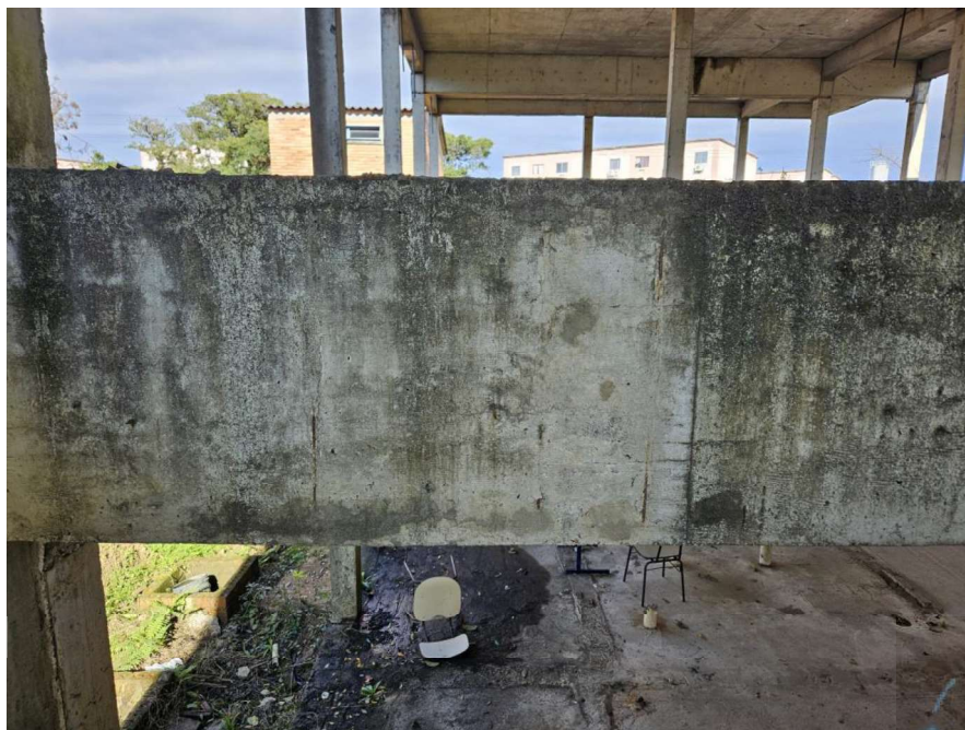
Foto 06 – 2º Pavimento – Edificação Estrutural Existente - Viga Escada
