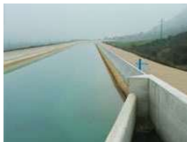
Figura 26 - Vertedor lateral em concreto
