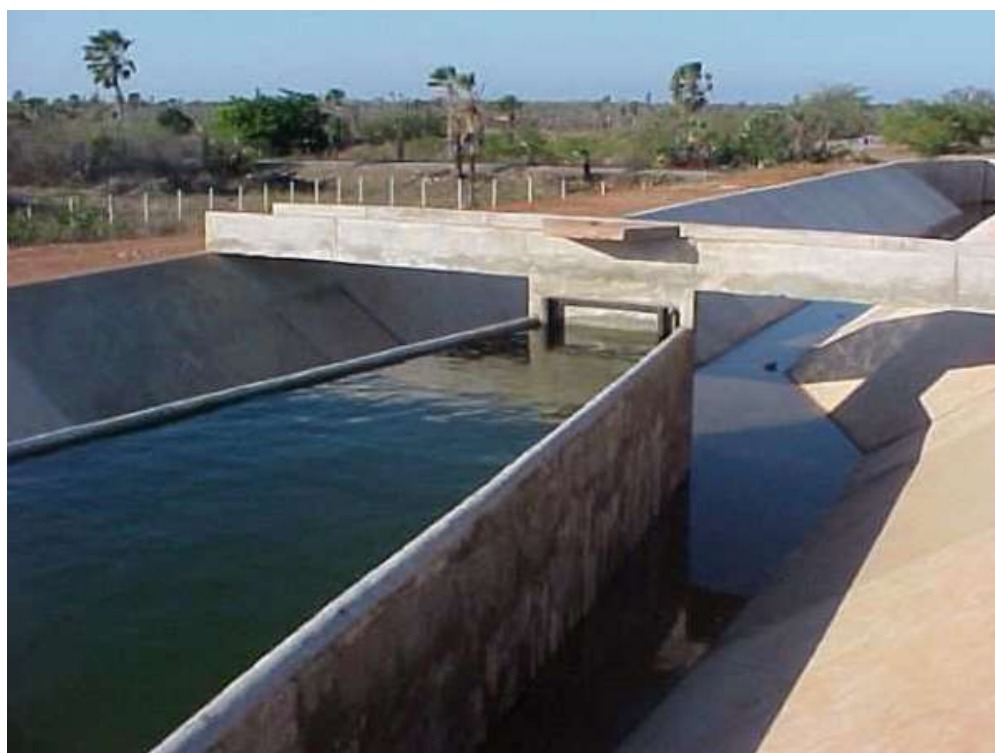
Figura 25 - Exemplo de vertedor bico de pato simples ( http://qiscombr.winconnection.net:8081/stvba/interna.asp?conteudo=fotointernagaleria&IDSubAlbum=5 )
