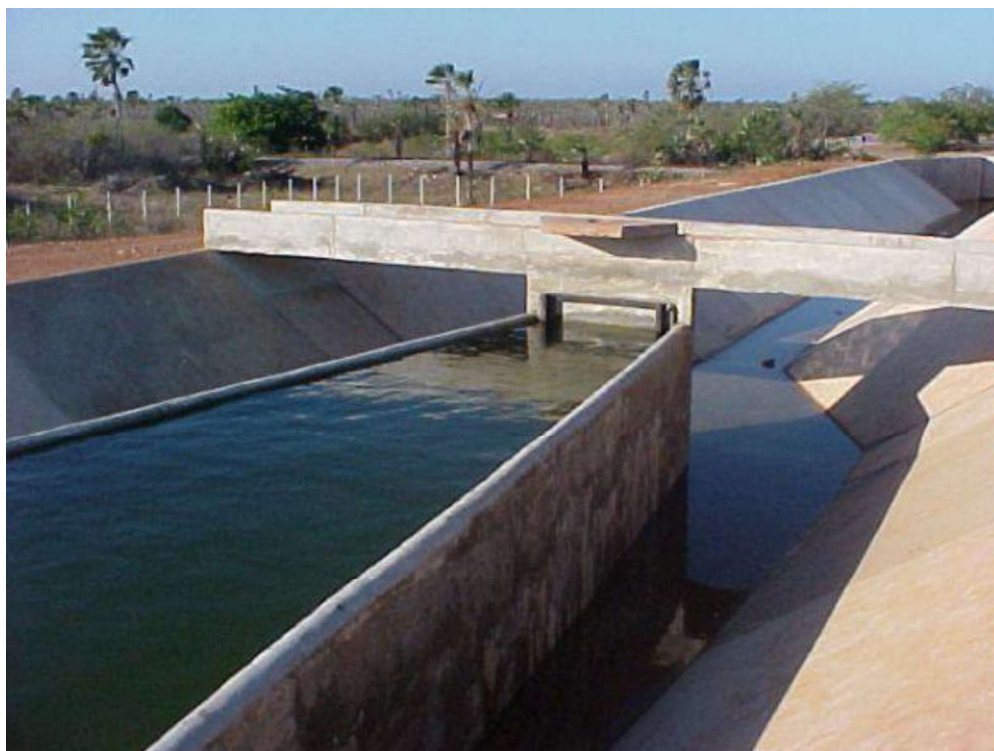
Figura 25 - Exemplo de vertedor bico de pato simples ( http://giscombr.winconnection.net:8081/stvba/interna.asp?conteudo=fotointernagaleria&IDSubAlbum=5 )
