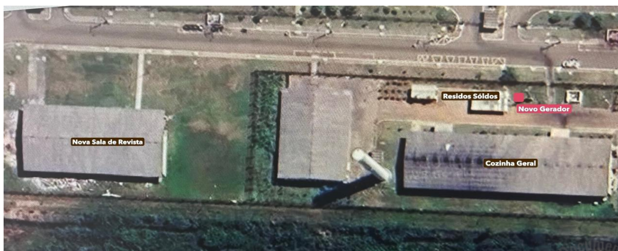
Vista Superior local a ser instalado o Grupo Gerador de 260 KV
