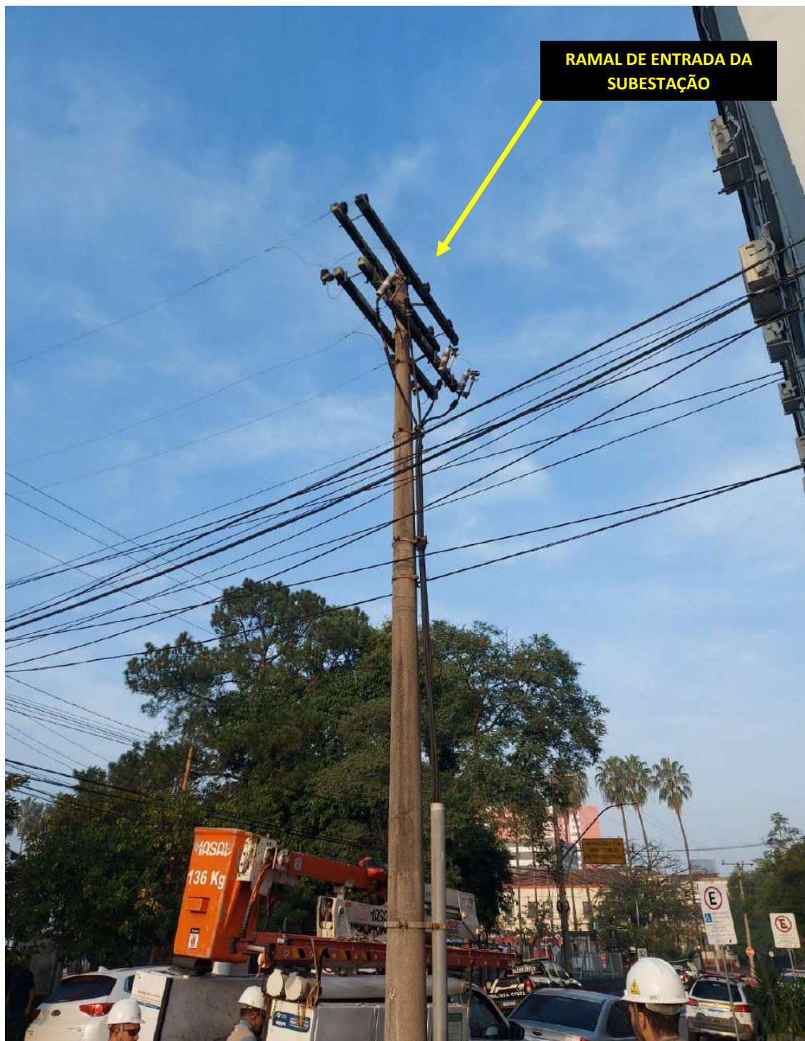
Figura 3 - Equipe CEEE e poste
