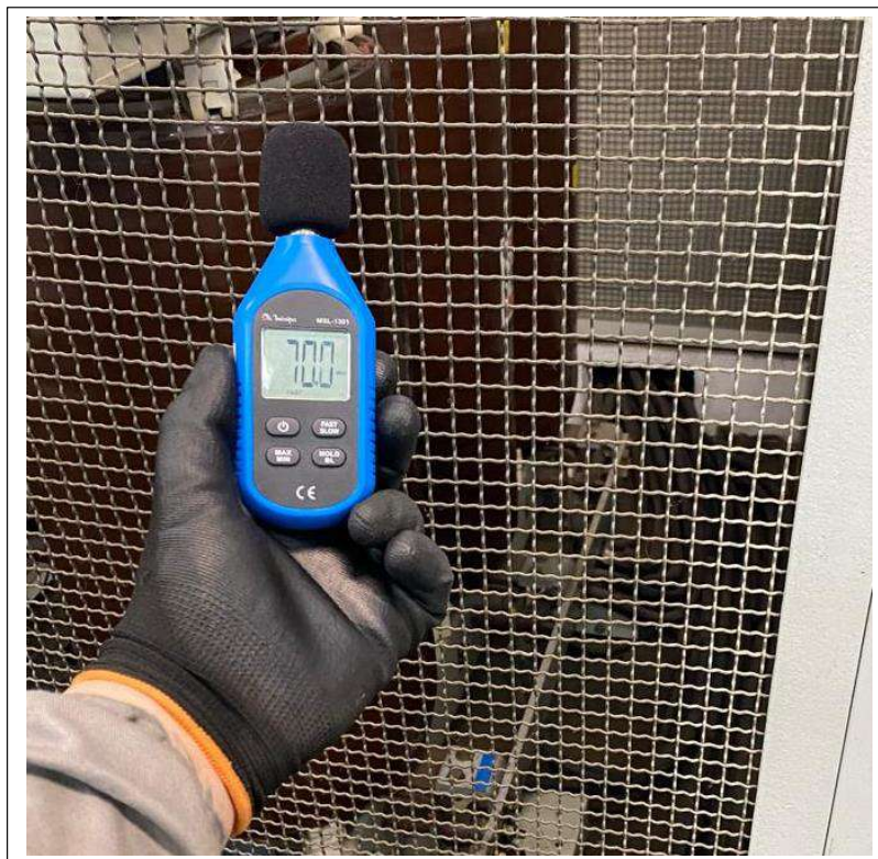
Figura 21 - Verificação dos níveis de ruídos da subestação
