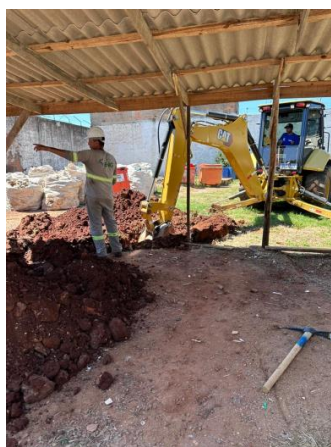
Figura 1. Instalação de dois novos Poços de Visita com gradeamento, para conectar à rede de esgoto sanitário do PR Passo Fundo e do IP de Passo Fundo à rede pública.
