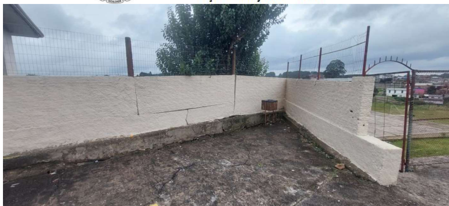
Figura 9 Muro danificado
