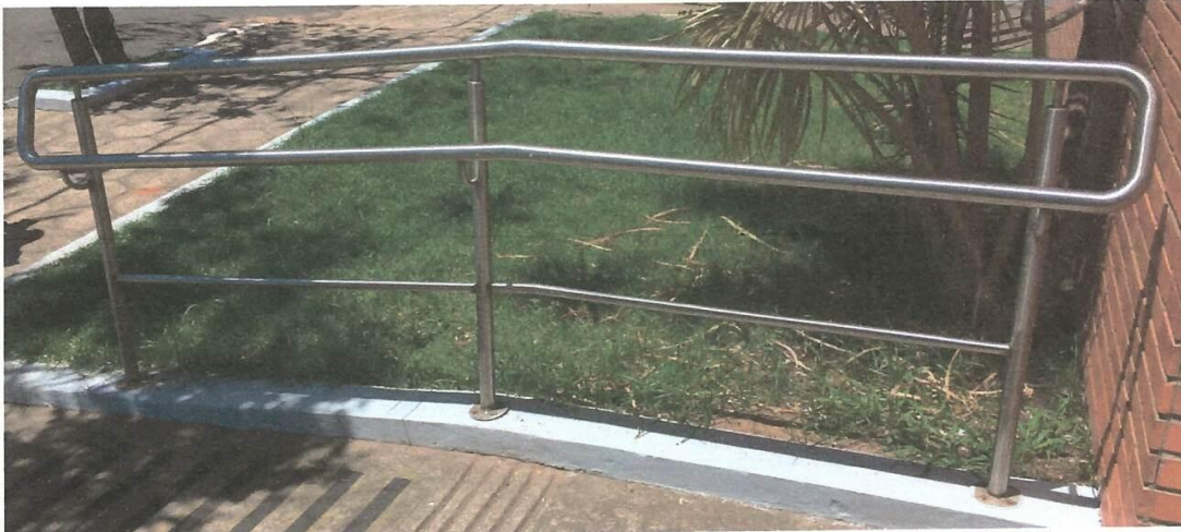
Fotografia do guarda-corpo com corrimão
