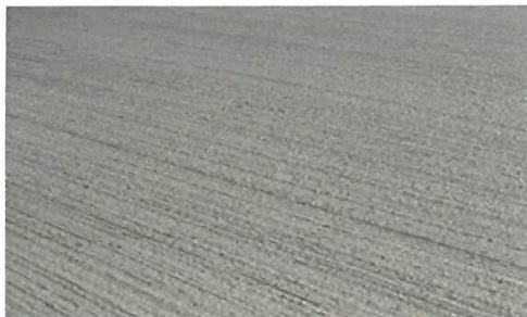
Fotografia do acabamento do piso
