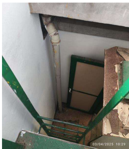
Figura 10 – Vista do respiro dos banheiros passando pelo espaço original do poço do elevador
