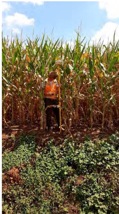
Figura 10 – Levantamento seção Transversal
