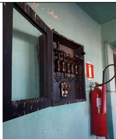
Fotografia 27 Painel elétrico existente na casa de máquinas
