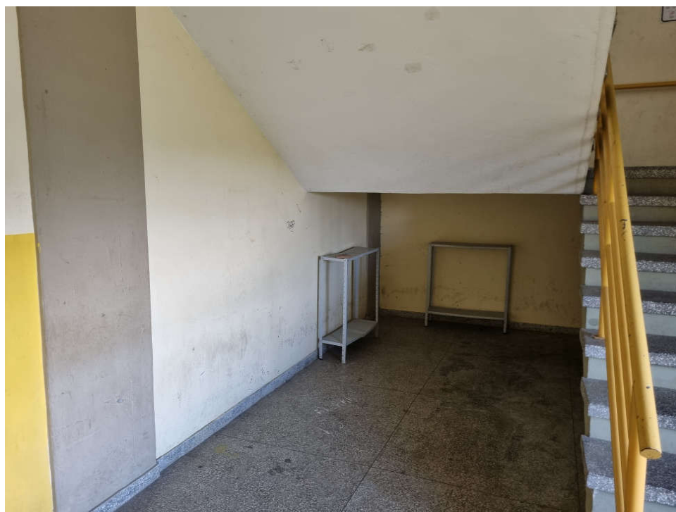
Figura 8 - Espaço no térreo junto a espera do elevador para instalação do armário com o painel de comando
