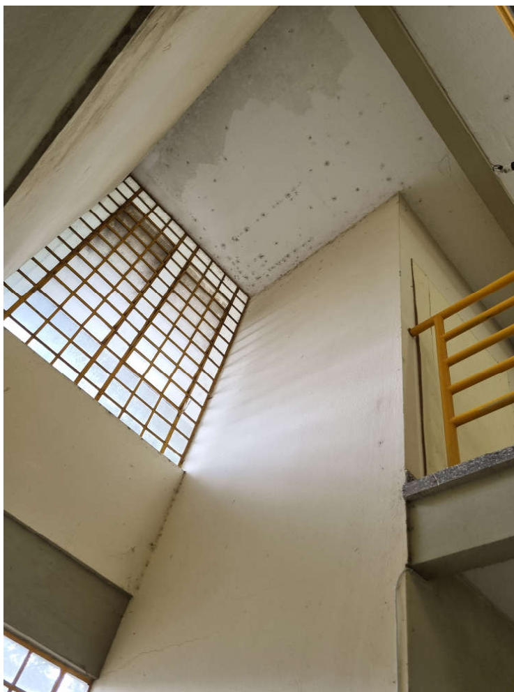
Figura 10 - Existem manchas de infiltração na laje das caixas d'agua que ficam acima da espera do elevador
