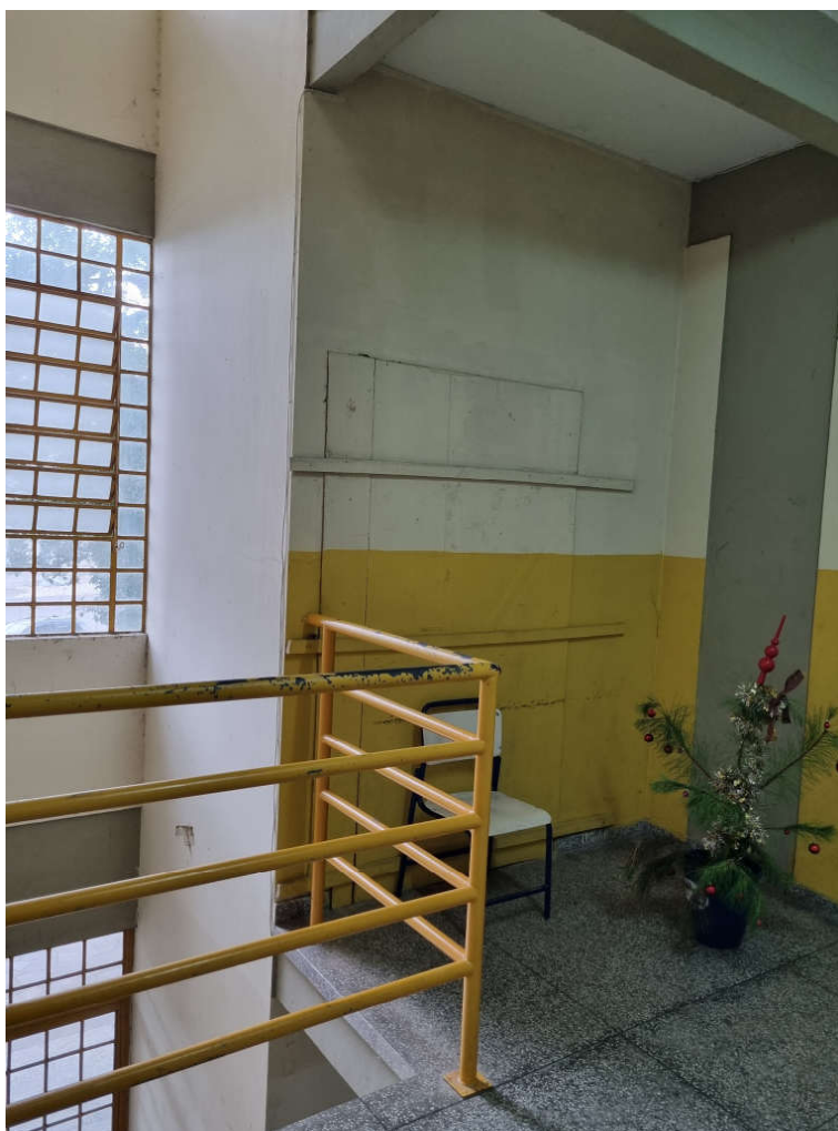
Figura 4 - Acesso ao elevador no segundo pavimento
