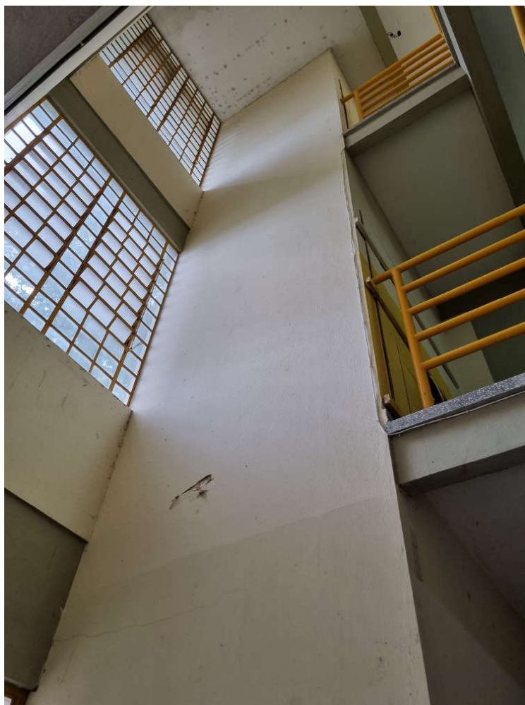
Figura 2 - Espera para o elevador feita na construção do prédio
