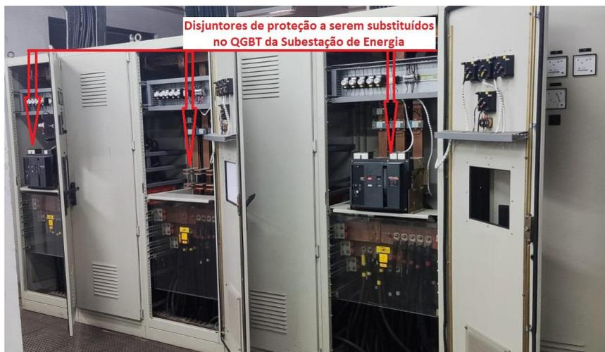
Figura 01: Sinalização dos disjuntores de proteção a serem substituídos no QGBT.
