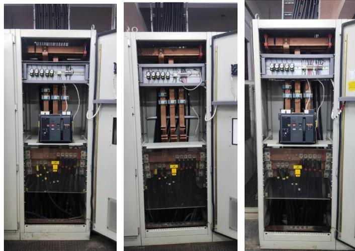
Figura 02: Detalhamento da instalação atual dos disjuntores de proteção.
