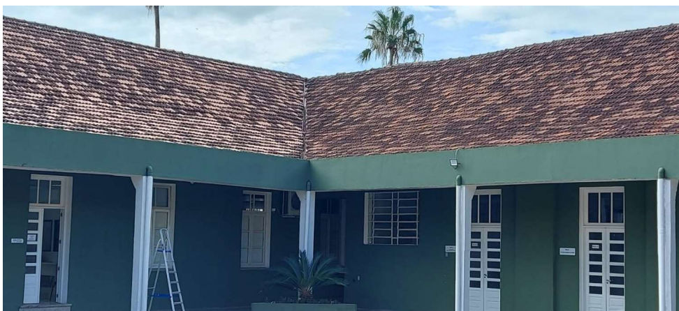
- Telhado da APM
