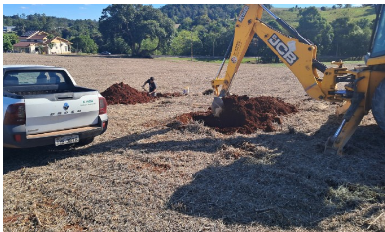
Fotografia 03: Local da escavação da trincheira T1 e do ensaio E2.
