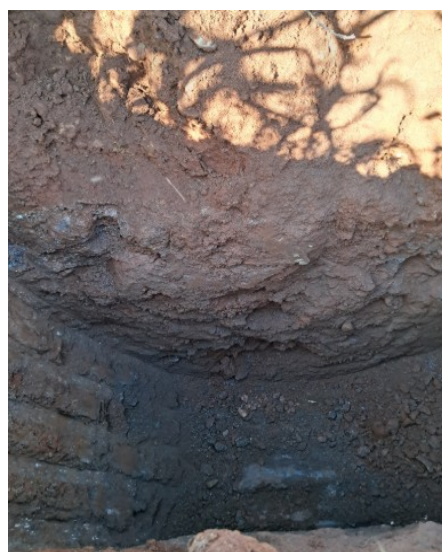
Fotografia 06: Perfil de solo da trincheira T2.
