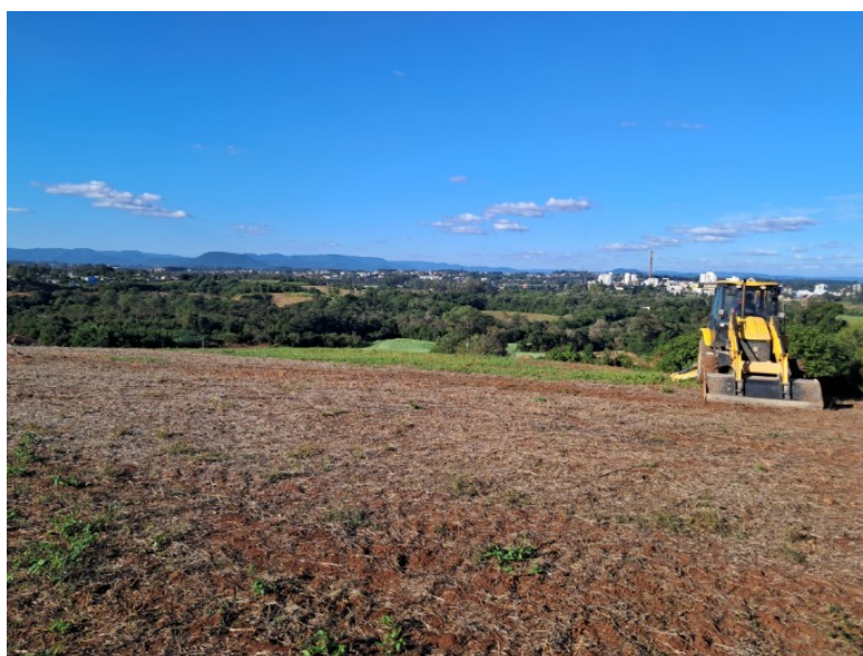
Fotografia 08: Local da escavação da trincheira T5 e local do ensaio E8.
