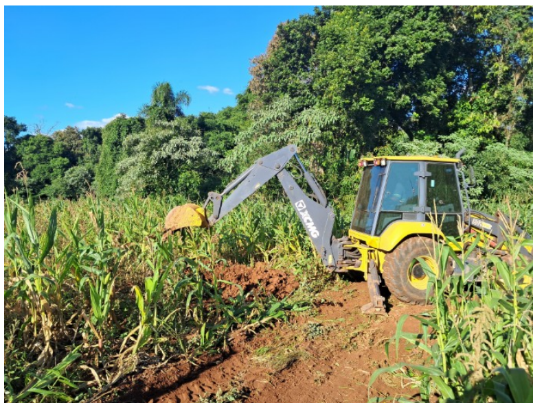
Fotografia 05: Local de escavação da trincheira T2.
