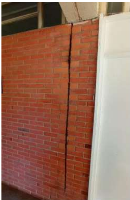
Fig. 5 e 6) Abertura da junta de dilatação e Abertura da junta no piso
