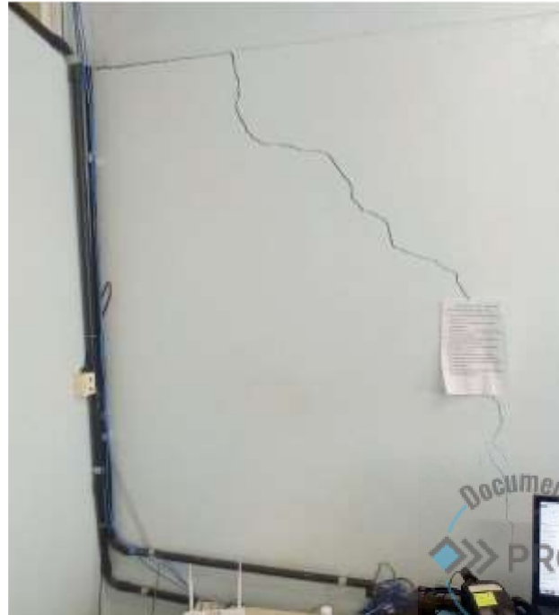
Fig. 5 e 6) Abertura da junta de dilatação e Abertura da junta no piso
