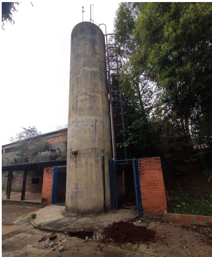
Fig.2) Vista do reservatório existente
