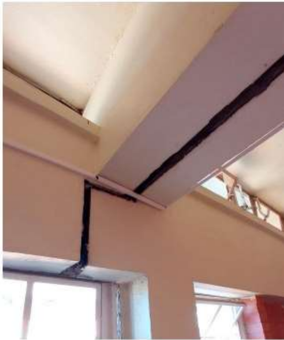
Fig. 5 e 6) Abertura da junta de dilatação e Abertura da junta no piso
