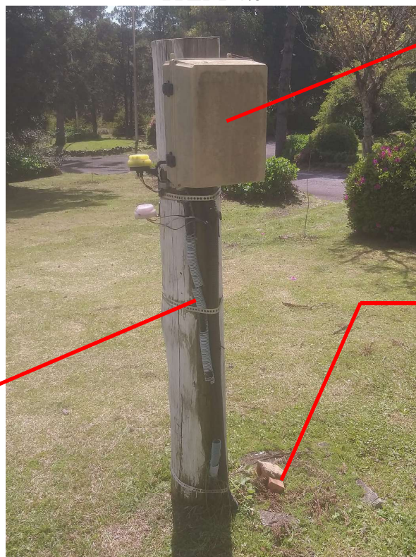
Comando 2 - Caixa de Disjuntores que fina na subida do SOLAR
