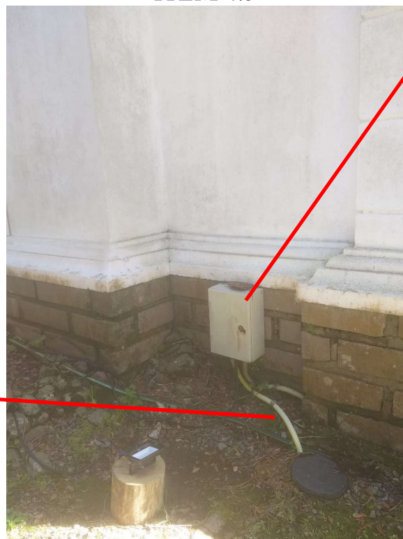
Comando 1 - Caixa de Disjuntores que fica ao Lado do SOLAR
