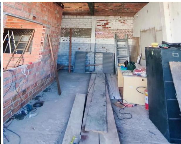
Ausência de Revestimento / Necessidade e Substituição em Piso – Alojamento Masculino
