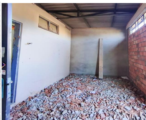
Ausência de Revestimento / Necessidade e Substituição em Piso – Alojamento Masculino
