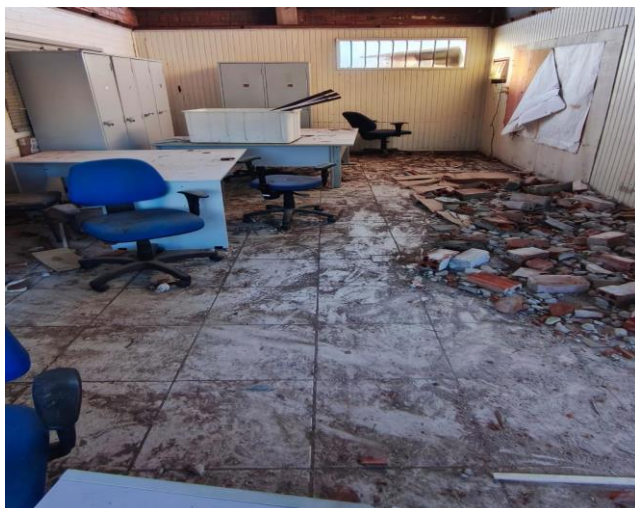
Ausência de Revestimento / Necessidade e Substituição em Piso – Alojamento Masculino
