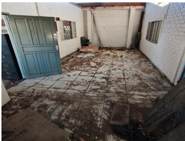
Ausência de Revestimento / Necessidade e Substituição em Piso – Alojamento Masculino
