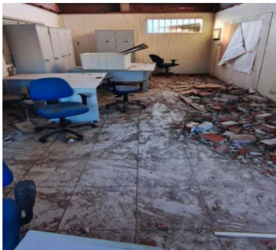
Ausência de Revestimento / Necessidade e Substituição em Piso – Alojamento Masculino
