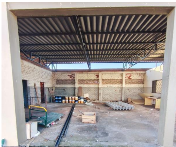
Ausência de Revestimento em Piso - Garagem de Carga e Descarga de Materiais
