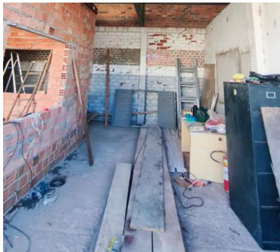
Ausência de Revestimento / Necessidade e Substituição em Piso – Alojamento Masculino
