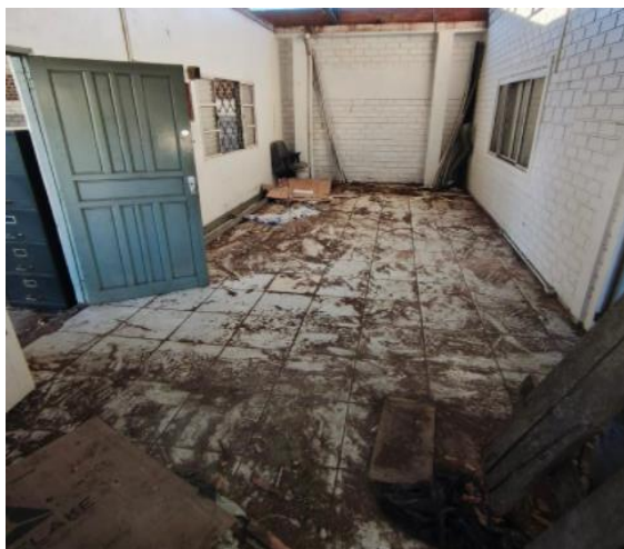
Ausência de Revestimento / Necessidade e Substituição em Piso – Alojamento Masculino
