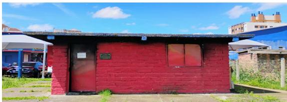
3 – Local de treinamento com encanamento para passagem de gás: Feito com pedras gres. Medida aproximada de toda extensão do piso de concreto: 6,60m x 5,70m. Base de concreto com aproximadamente 10cm de espessura. Deve ser retirada, além das pedras e piso de concreto, as telas
