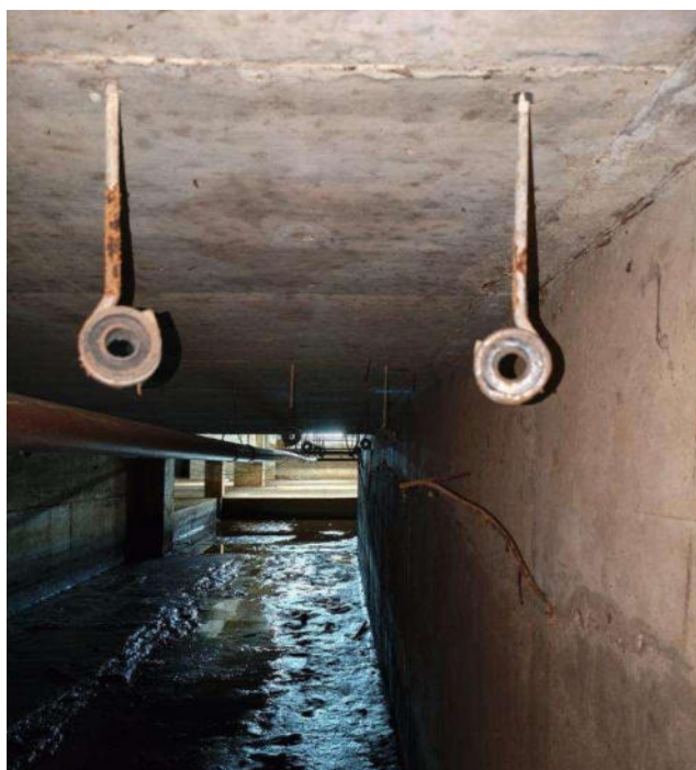
Medição do aterramento dos 2 cabos rompidos da subestação e percurso onde os cabos foram retirados.
