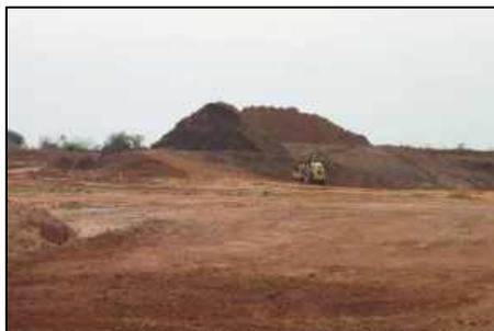
Foto 19. Extração de material para aterro em loteamento 26/08/15 (PE - 12)
