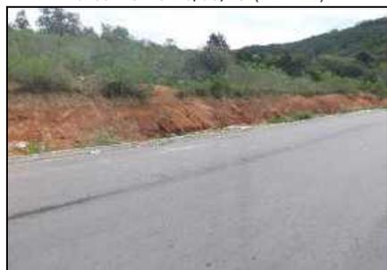
Foto 21. Talude sem cobertura vegetal com ocorrência de sulcos e sem canaletas de drenagem pluvial 04/09/15 (PE - 14)
