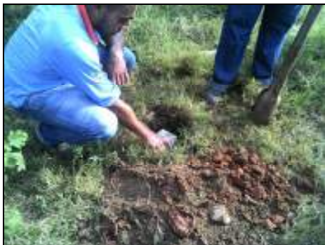
Foto 30. Dique da FIERGS – Implantação de marcos
