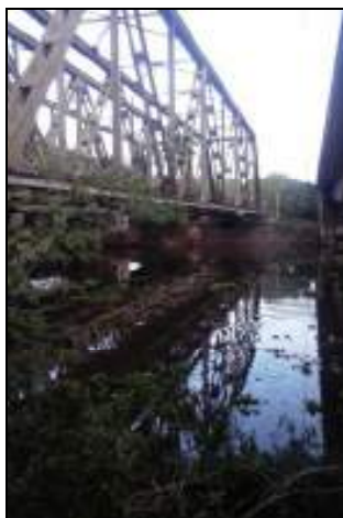
Foto 1. Seção topobatimétrica - ponte BR-116
