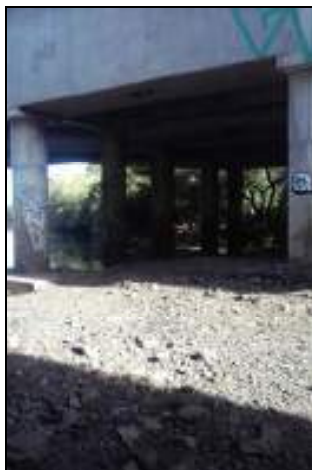
Foto 7. Seção topobatimétrica - Ponte Free Way
