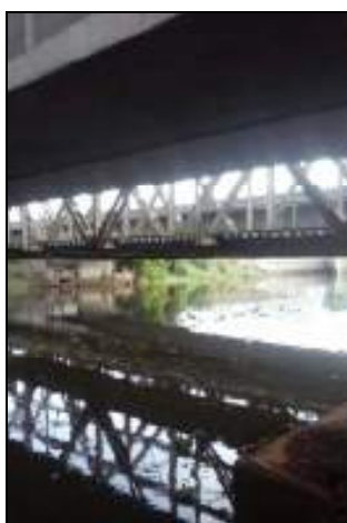
Foto 3. Seção topobatimétrica - ponte BR-116
