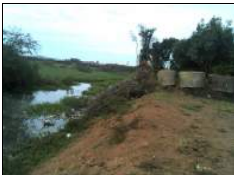
Foto 32. Dique da FIERGS – Vista do Dique
