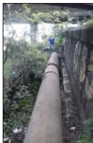
Foto 4. Seção topobatimétrica - ponte BR-116
