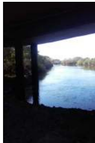
Foto 8. Seção topobatimétrica - Ponte Free Way
