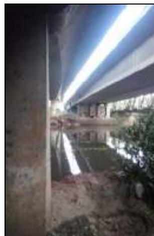
Foto 2. Seção topobatimétrica - ponte BR-116
