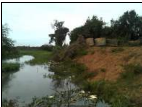
Foto 34. Dique da FIERGS – Vista Norte
