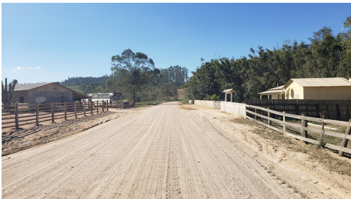
Figura 2 – Ocupação da faixa de domínio
