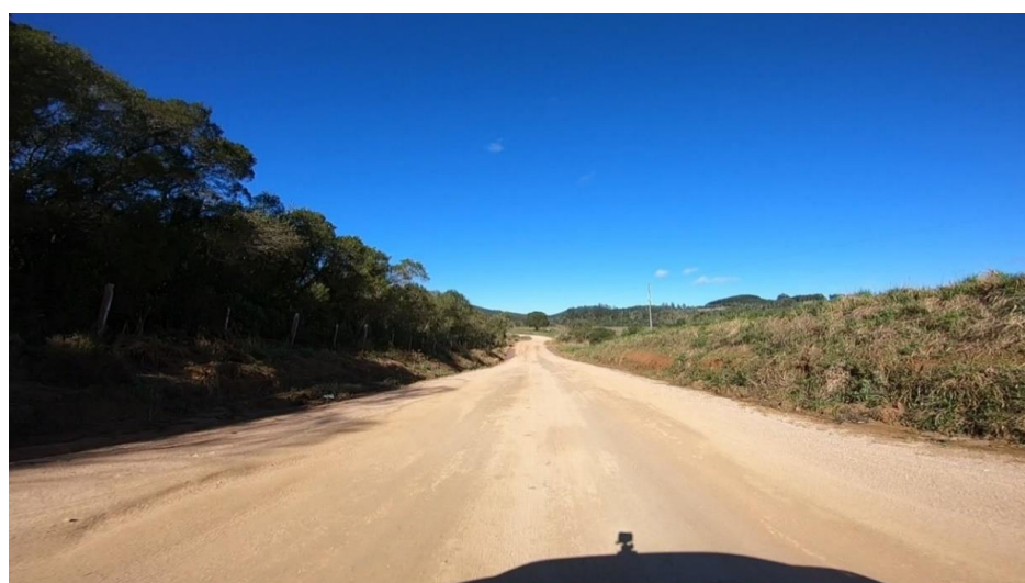
Figura 1 – Início do trecho (km 10+100)
