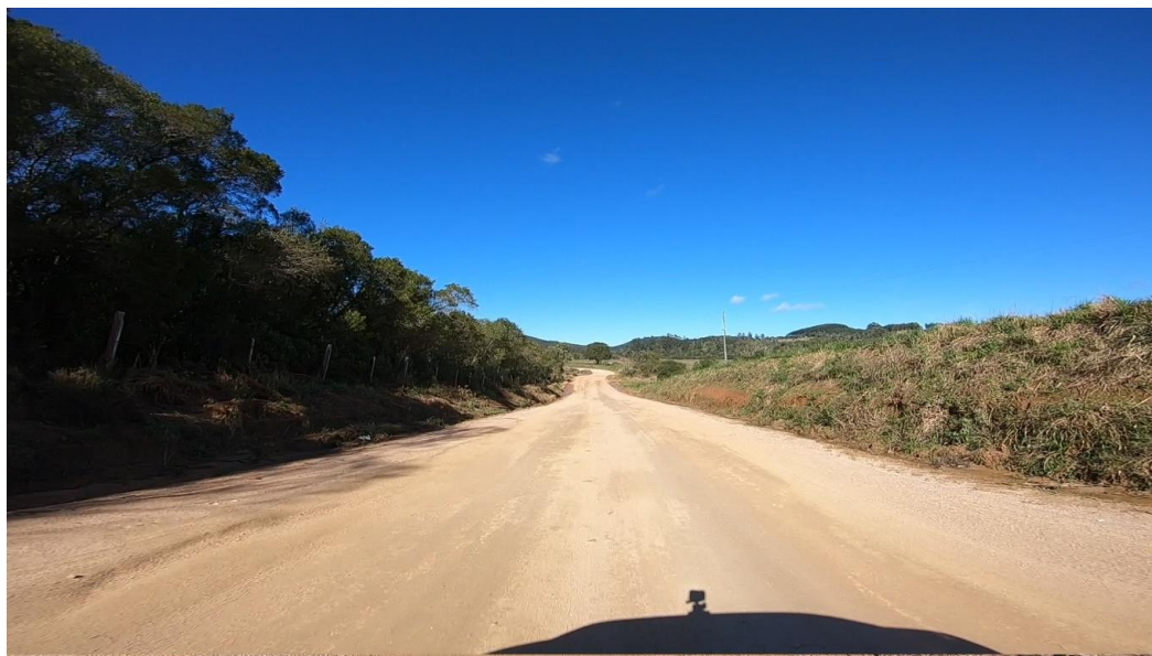
Figura 5 – Início do trecho Lote 2 - km 10+100 (coordenadas X: 187.461,908; Y: 1.617.796,644)
