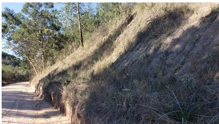
**Foto 06 – Talude de corte sujeito a movimento de massa e em processo de erosão**
