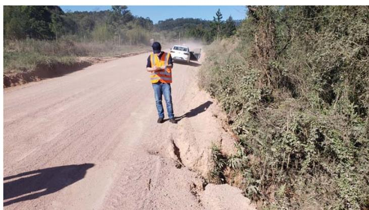
**Foto 07 – Processo erosivo junto a lateral da pista**
