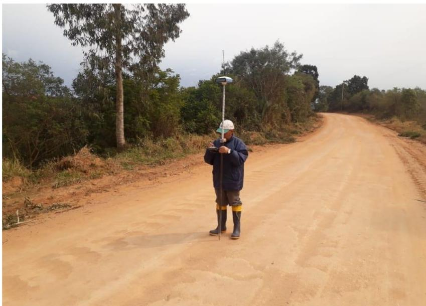
**Figura 15 – Estaqueamento do eixo de referência**
