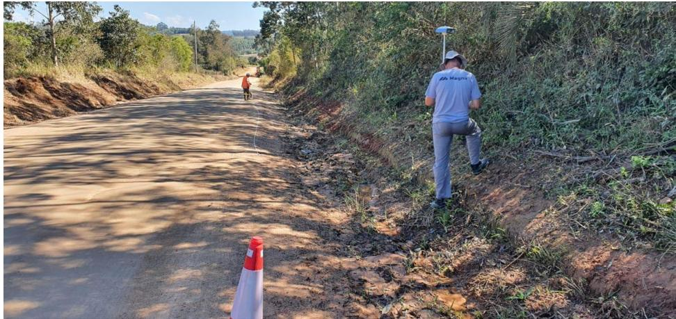
**Figura 16 – Levantamento seção Transversal**
