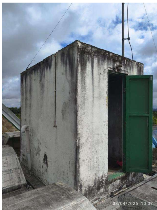
Figura 8 – Vista externa da casa de máquinas
