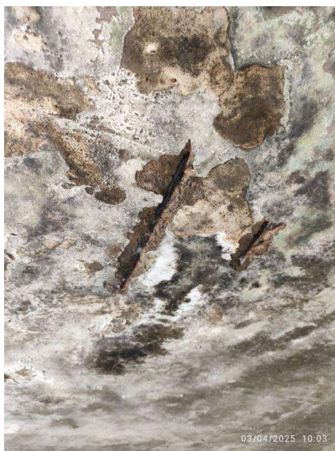
Figura 9 – Vista interna da laje casa de máquinas
