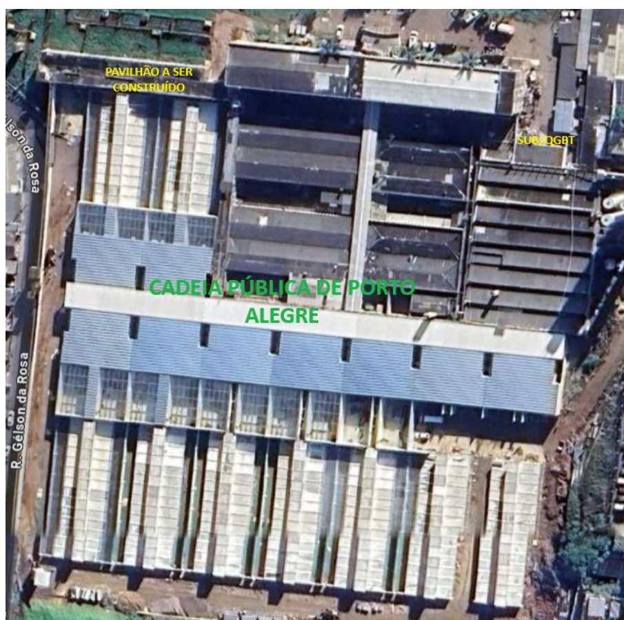
Figura 1 - Localização da cadeia, subestação de energia elétrica e pavilhão de trabalho.
