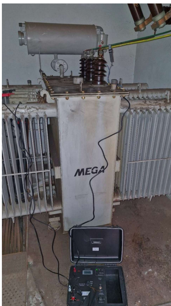
Fotos 17 e 18: Detalhe do transformador e secador de sílica, indicando saturação.
