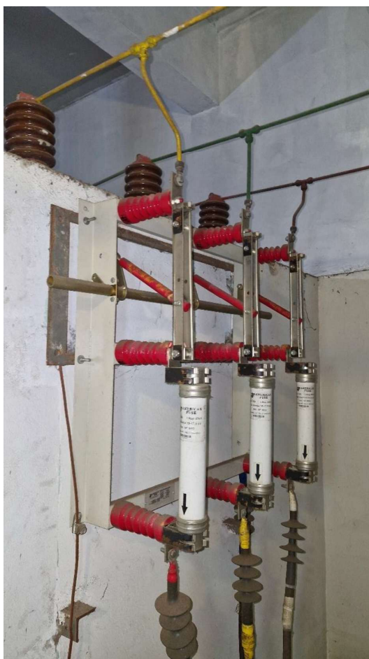
Foto 4 (esquerda): Chave seccionadora tripolar, com fusíveis, Subestação Auxiliar 1.
