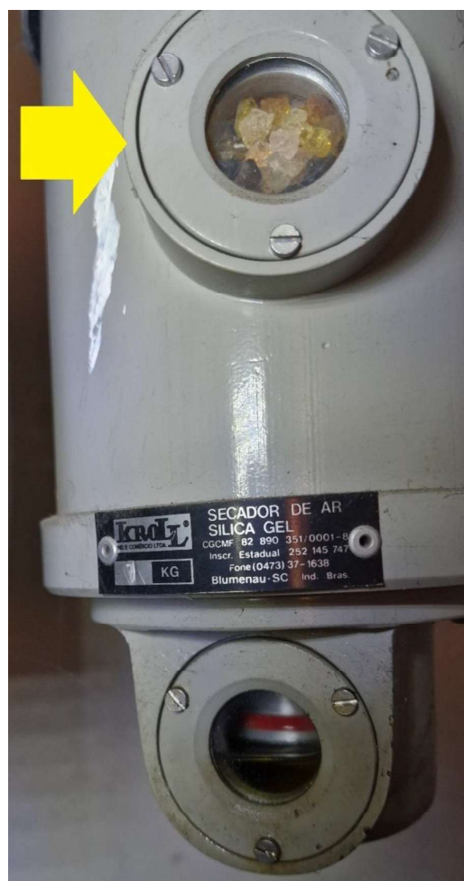
Fotos 17 e 18: Detalhe do transformador e secador de sílica, indicando saturação.
