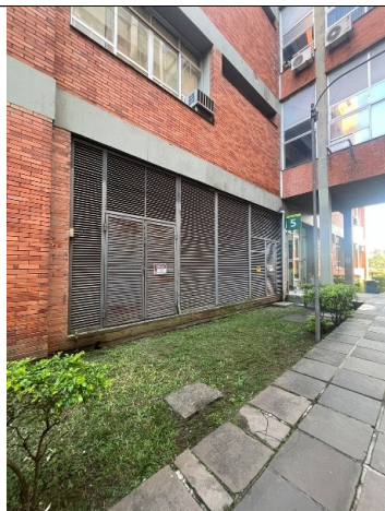
Imagem 1: Entrada externa da subestação.
