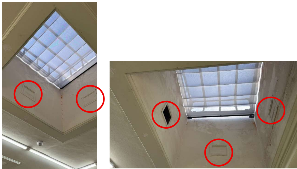
Imagem 9 e 10: Local de instalação das venezianas de ventilação
