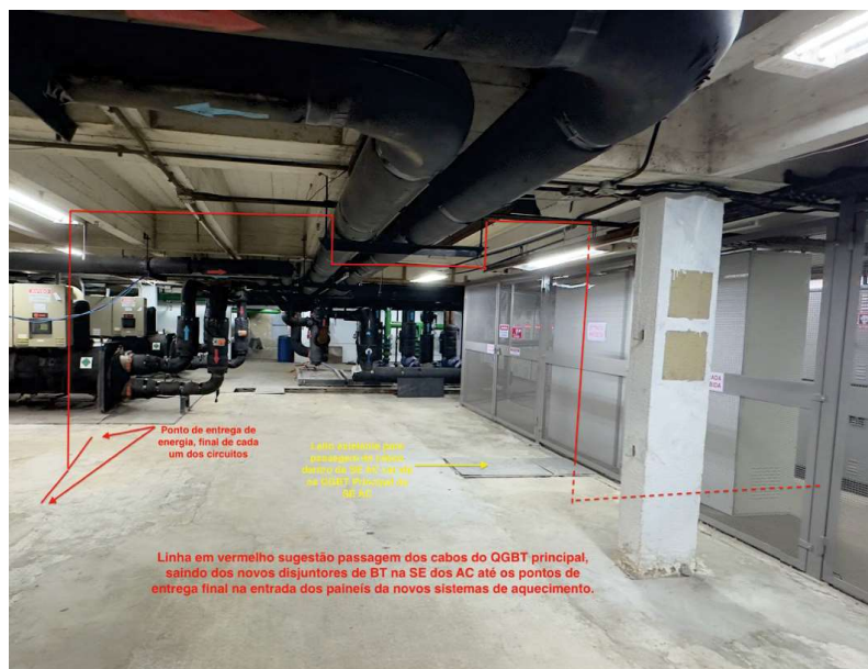
Figura 2: Parte externa da SE dos AC e sugestão passagem dos cabos indicando nas setas local onde serão instalados os painéis de aquecimento.
