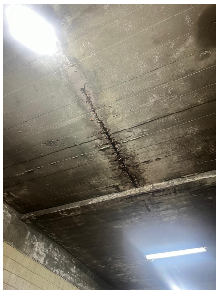
Laje da área de lavagem
