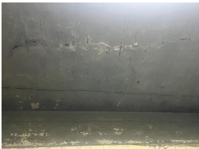
Laje da área de lavagem
