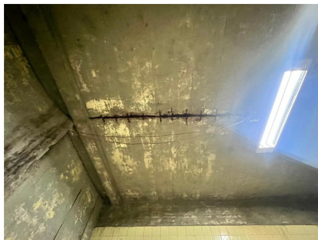
Laje da área de lavagem
