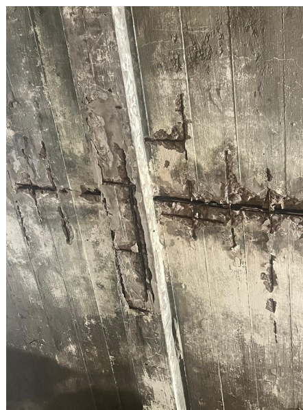
Laje da área de lavagem
