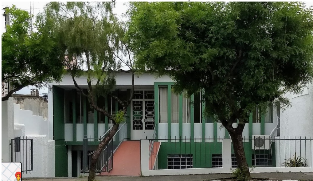
Imagem 1: Fachada do prédio
